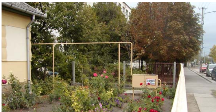
1. ábra Gázbekötés légvezetékekkel
